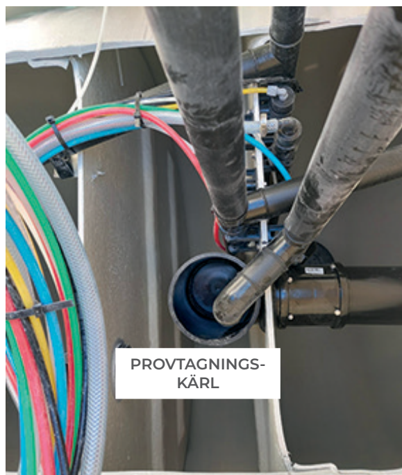
Bild 2: Provtagningskärlet utan röd slang
