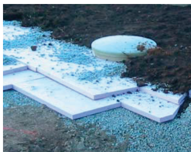
Frostsikring av tanker
