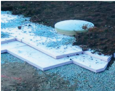
Figur 17: Frostsikring av tanker
