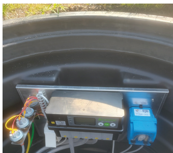
Figur 7: Plattan är fäst vid "vårtorna" i halsen.
