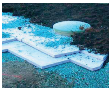
Frostsikring av tanker
