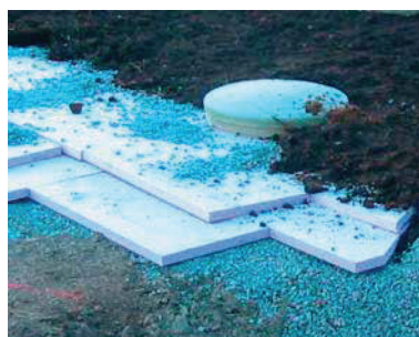
Frostsikring av tanker
