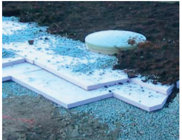
Figur 5. Frostsikring av tanker
