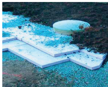
Frostsikring av tanker
